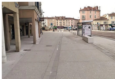
La rue du 4-Septembre (ici côté sud) a vu la superficie de ses trottoirs - en béton bouchardé - tripler en superficie. En médaillon : le béton - un C25/30 classé XF2 à base de ciment Vicat CEM I 52,5 - intégrant du Comblanchien, de calibre 20/40 et 16/22.
