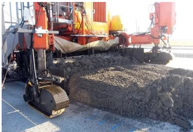
La Wirtgen SP-500, équipée de goujonneuses latérales, en action. Grâce à ses capteurs, elle permet une précision de l'ordre de 5 mm.
