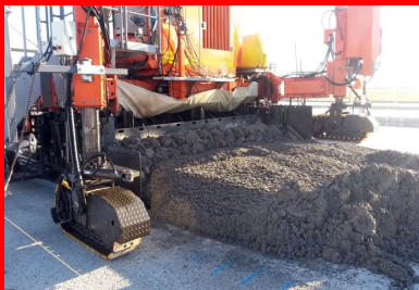
La Wirtgen SP-500, équipée de goujonnières latérales, en action. Grâce à ses capteurs, elle permet une précision de l'ordre de 5 mm.
