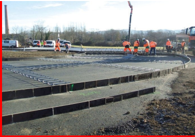
Chaque branche du giratoire a été dotée d'une dalle de transition (au premier plan) entre la chaussée en enrobé
