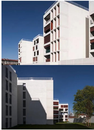
L'opération combine neuf immeubles plots implantés en retrait de la rue.
