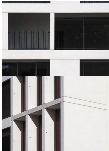
Réalisé en béton blanc, les loggias composent une peau épaisse et qualifient l'opération.
