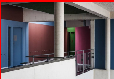
Le travail sur la couleur contribue à rendre lisibles les éléments de structure en béton clair brut.
