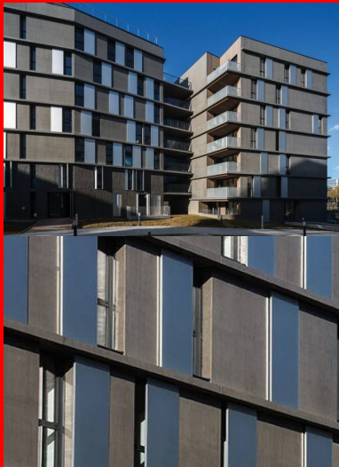
Les façades est donnant sur l'intérieur de l'îlot, au design tout aussi graphique mais plus sobre, accueillent principalement les fenêtres des chambres.
