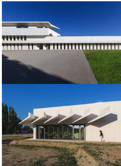
La modénature de la façade, constituée d'éléments préfabriqués en béton blanc, assure des protections solaires passives aux baies.
