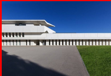
La modénature de la façade, constituée d'éléments préfabriqués en béton blanc, assure des protections solaires passives aux baies.
