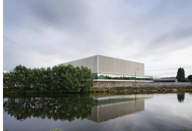
Façade nord sur le canal. Le choix de matériaux pérennes et le soin de leur mise en œuvre participent de l'image du palais, entre les fines colonnes de béton, la double peau vitrée assure un tampon thermique.
