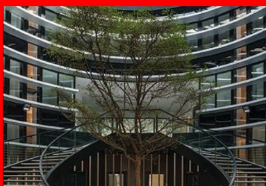
L'atrium amène la lumière au cœur du bâtiment et, par ses ouvertures en partie haute, participe à sa ventilation naturelle.
