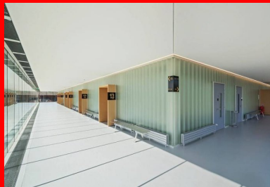
Originalité de ce palais de justice, la salle des pas perdus. Placée au 1er étage, en périphérie des salles d'audience, elle s'ouvre sur l'extérieur par des baies vitrées.
