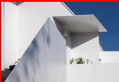
Le graphisme des escaliers en béton préfabriqué.
