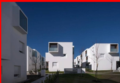
Dans l'alignement des immeubles de l'îlot Jouanicot, le traitement des loggias évite les vues en vis-à-vis.
