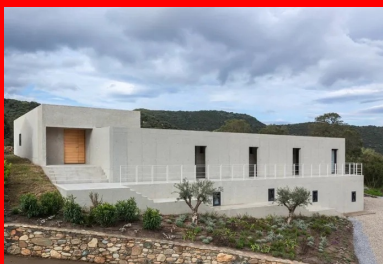
La maison se déploie par un jeu de volumes en béton sablé aménagés dans la pente.
