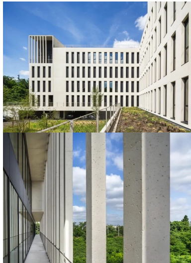
Une pergola accessible double la façade nord.
