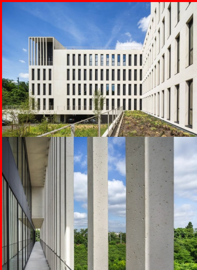
Une pergola accessible double la façade nord.
