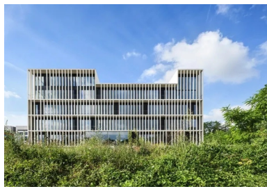
Une pergola accessible double la façade nord.
