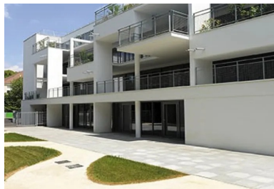
Les éléments de la structure béton sculptent la façade ouest.
