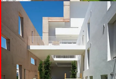
Derrière ce mur, les coursives d'accès aux logements sont particulièrement soignées pour faire du moment du « rentrer chez soi », un temps d'exception.
