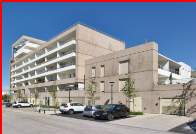
Le long de l’avenue des tirailleurs, le bâti marque un épannelage dégressif passant du r+8 au r+2.
