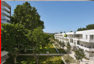
En limite est, le bâti en r+2 est plus domestique et volontairement poreux pour préserver les vues vers le panorama sur la chaîne saint-cyr.
