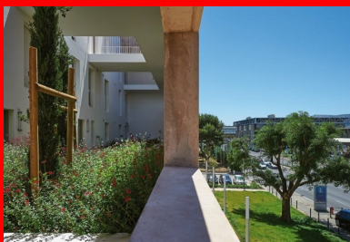
Le mur en béton teinté, le long du boulevard, crée un écran à la fois acoustique et visuel.
