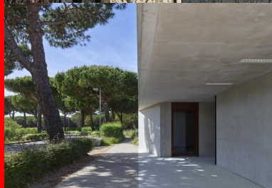
Le débord en porte-à-faux de la toiture crée un auvent ombragé.
