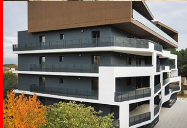
Bâtiment haut, angle nord-ouest, les loggias de la façade principale se prolongent en balcon vers le nord.
