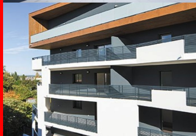
Façade principale du bâtiment haut avec ses grandes loggias orientées sud-ouest dont les rives en béton peint en blanc soulignent le dépiement.
