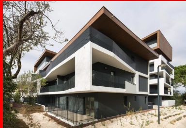
Angle sud du bâtiment bas, les loggias s'ouvrent sur l'extérieur de l'opération et bénéficient de la même orientation sud-ouest que celles du bâtiment haut.
