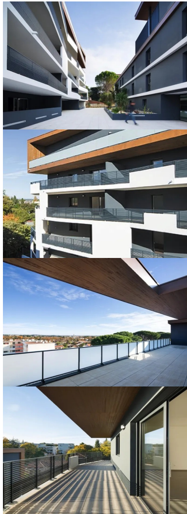
Le parvis entre les deux bâtiments crée un socle commun.
