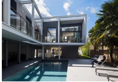
Le rez-de-chaussée est consacré à la piscine, au stationnement sous dalle ainsi qu'aux locaux techniques. Les espaces habitables sont aménagés à l'étage.
