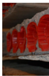
Figure 11 : exemple de planchers alvéolaires précontraints.
