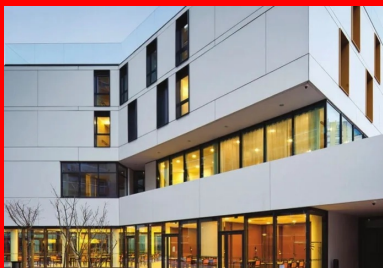
Maison de retraite EPHAD Annie Girardot, Paris. Ce projet, pilote pour la mise au point du référentiel de certification Habitat & Environnement EHPAD, porte une attention particulière au confort et à l'accessibilité des occupants, population qui doit pouvoir disposer d'un temps d'évacuation adapté à ses vulnérabilités.
