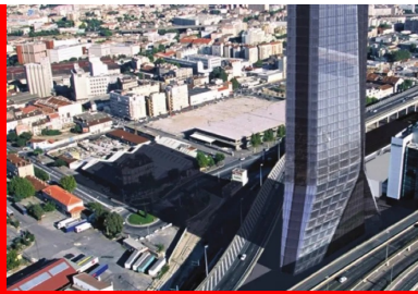
Tour CMA-CGM, Marseille. L'évacuation des immeubles de grande hauteur (IGH) est une opération longue et complexe qui nécessite tout le soutien structurel que peuvent apporter les qualités de résistance au feu du matériau béton.
