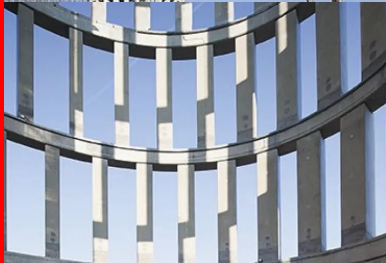
Chacune des 12 travées du fût se compose de 28 poteaux de section trapézoïdale de 4,8 m de haut encastres en pied et en tête sur les poutres annulaires.
