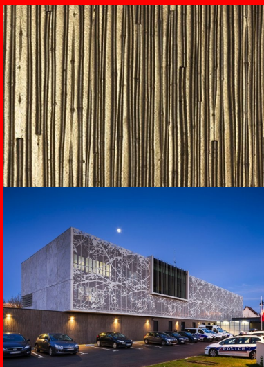
au rez-de-chaussée, le parement extérieur des murs à co-rages intégrés isolés est matriçé et présente un motif de bambou.
