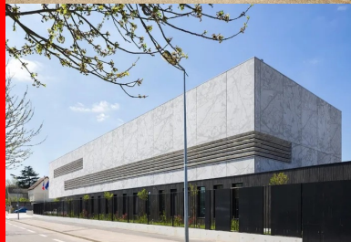
Les façades nord et ouest sont habillées de béton orné.
