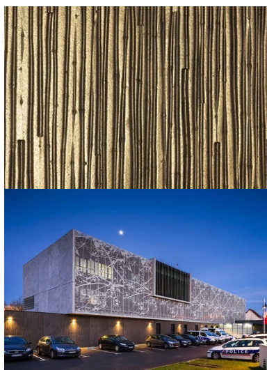
au rez-de-chaussée, le parement extérieur des murs à co-rages intégrés isolés est matricé et présente un motif de bambou.
