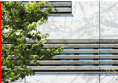
Les lames de béton protègent de l'extérieur mais laissent passer la lumière naturelle.
