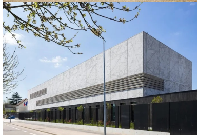
Les façades nord et ouest sont habillées de béton orné.
