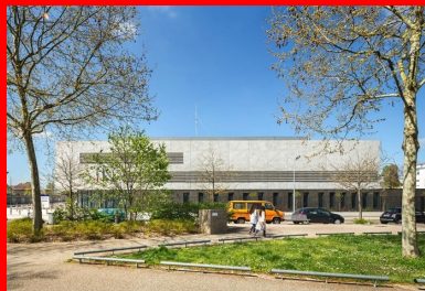
Le rythme vertical des baies du RDC répond à l'horizontalité des lames de béton des étages.
