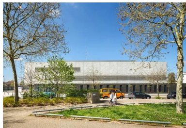
Le rythme vertical des baies du rdC répond à l'horizontalité des lames de béton des étages.
