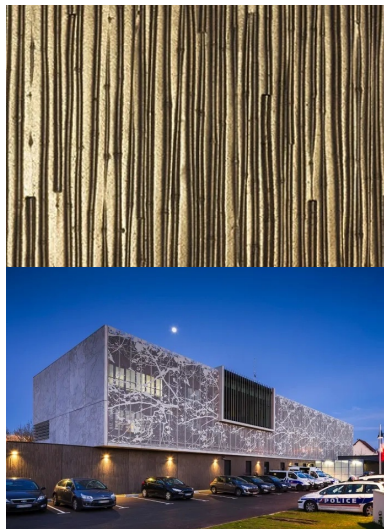
au rez-de-chaussée, le parement extérieur des murs à co-rages intégrés isolés est matricé et présente un motif de bambou.
