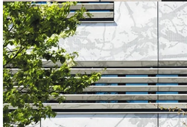
Les lames de béton protègent de l'extérieur mais laissent passer la lumière naturelle.
