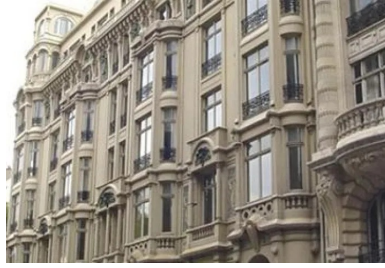
1 er immeuble en béton armé, rue Danton (75006), construit par et pour François Hennebique (arch. Edouard Arnaud) afin de prouver que ce nouveau procédé pouvait donner l'illusion des matériaux classiques.
