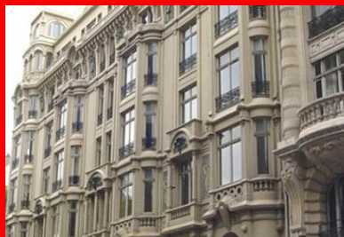
1 er immeuble en béton armé, rue Danton (75006), construit par et pour François Hennebique (arch., Edouard Arnaud) afin de prouver que ce nouveau procédé pouvait donner l'illusion des matériaux classiques.
