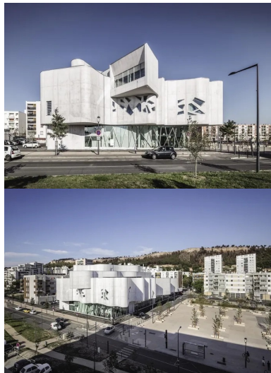
L'émergence de la litanerie du personnel en partie haute, face au grand axe du quartier.
