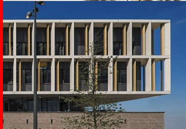
Les brise-soleil en béton assurent une protection efficace et dégagent une galerie à la manière d'un péritère.
