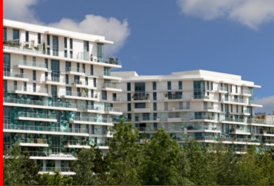
Le bâtiment est habillé d'éléments verriers dont les nuances de vert rappellent le parc qui lui fait face.
