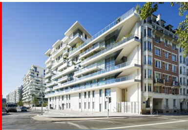
sur l'avenue Lefauchoux, les balcons filants en béton blanc accompagnent l'étrétement horizontal du bâtiment.
