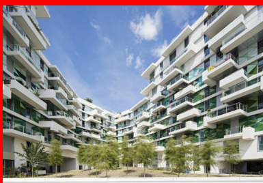
À l'intérieur de l'îlot, le foisonnement des balcons forme un paysage vertical qui envahit les façades.
