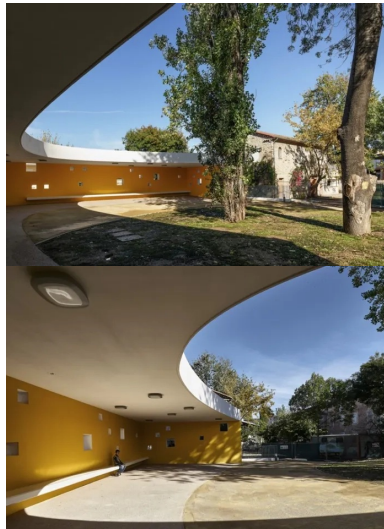
La ligne courbe de l'auvent et du porte-à-faux du préau qui caractérise le projet.
