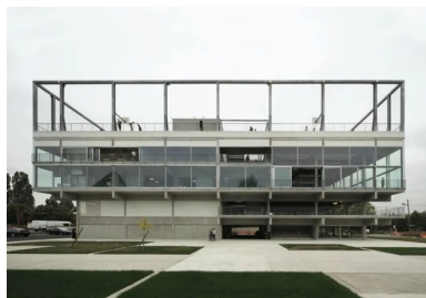
Pas de hiérarchisation des façades qui sont traitées selon le même principe.
