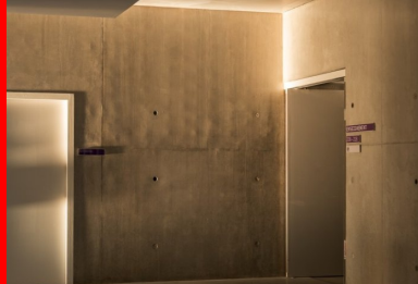
La présence intérieure du béton favorise la pérennité du bâtiment et l'inertie thermique.
