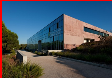
La façade principale, ouverte au nord, est totalement vitrée et animée d'une signalétique surdimensionnée.
