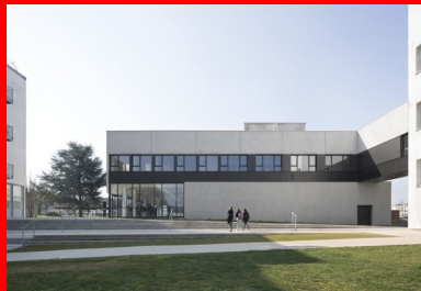
Les parois aveugles en béton brut matricé de la salle polyvalente ancrent l'édifice dans le sol, tandis qu'à l'étage les salles de travail s'ouvrent par de généreuses baies vitrées sur la vue lointaine.
