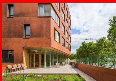
une terrasse généreuse prolonge la salle à manger, au premier niveau du pôle d'hébergement pour personnes âgées.
