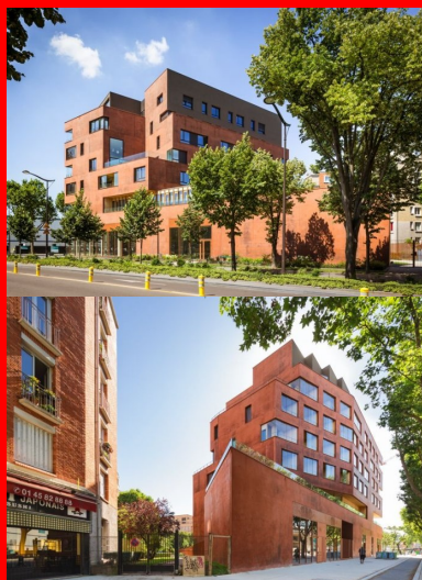
Le socle, sur deux niveaux, suit l'alignement urbain et assoit le bâtiment, vu comme un tout depuis la rue.
