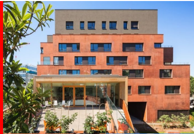
Le centre d'accueil de jour bénéficie d'un bel espace extérieur associant terrasse et espace planté.
