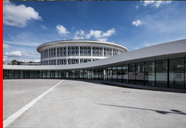
La façade largement vitrée de l'extension rend visible de l'extérieur ce qui se passe dans le bâtiment et invite à entrer.
