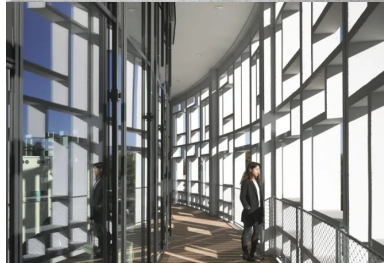
La peau vitrée placée en retrait des claustras engendre aux premier et second étages une coursive circulaire.
