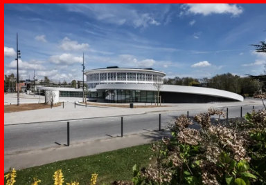
L'acrotère blanc en béton dessine un renforcement qui libère au sol un vaste parvis.
