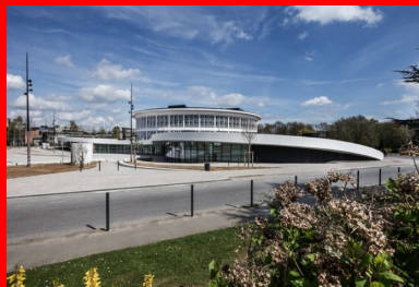
L'acrotère blanc en béton dessine un renforcement qui libère au sol un vaste parvis.
