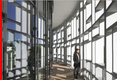
La peau vitrée placée en retrait des claustras engendre aux premier et second étages une coursive circulaire.
