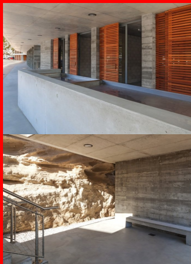
Le porte-à-faux de la dalle de l'esplanade vient créer une ombre protectrice sur les box et le banc de vente.
