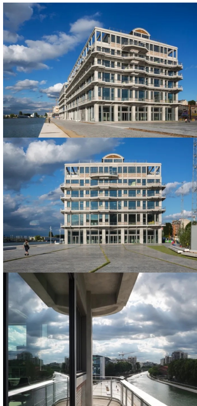
1 400 m de coursives ceinturent l'imposante structure sur ses quatre faces.
