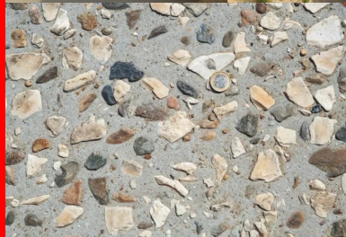
Le béton « cyclopéen » (voirie et parking).
