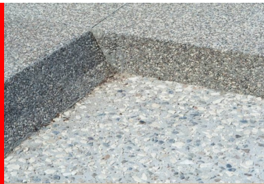
Des bordures inclinées pour une transition douce entre trottoirs et voie.
