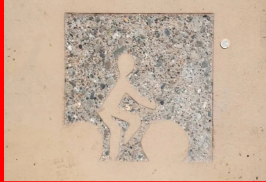
Les motifs ont été obtenus par sablage du béton recouvert de pochoirs créés par la plasticienne Sophie Balas.
