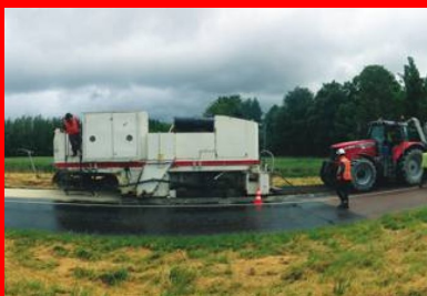
L'atelier de retraitement mobile à froid ARC 700 d'Eiffage, équipé du dispositif Recyclean®.
