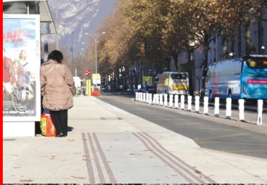
Des bandes rugueuses de couleur grenat, créées sur le béton désactivé, signalent la présence de voies cyclables.
