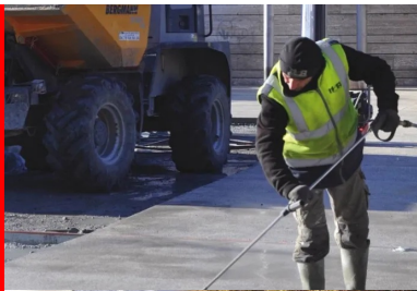
L'une des dernières parcelles de béton du parvis, en cours de désactivation au nettoyeur haute pression.
