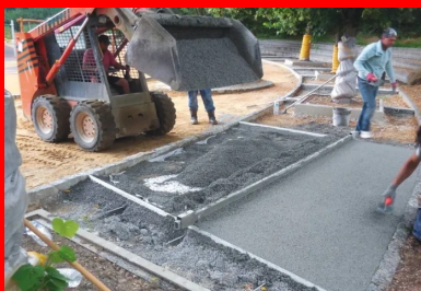
Le béton a été acheminé à l'aide d'une chargeuse et mis en œuvre manuellement par l'équipe de Val-de-Loire Environnement.
