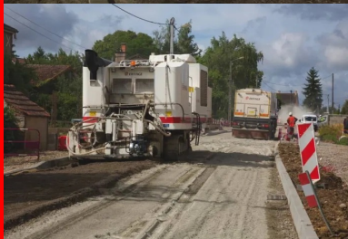
L'ARC 1000® permet d'homogénéiser la structure existante sur toute la largeur de la chaussée.
