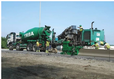
Sur le nouveau tronçon, 18 500 m de dispositifs de retenue en béton ont été coulés en place.
