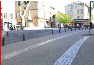
Les cours ont reçu un revêtement de béton désactivé avec des cailloux concassés clairs et un calépinage de bandes structurantes en pierres calcaires naturelles Cénia.
