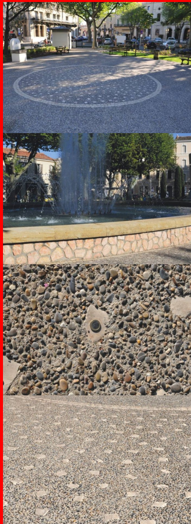
Le béton désactivé avec granulats roulés de Durance, cloutés de petits pavés calcaires, a métamorphosé le square Charles-de-Gaulle.
