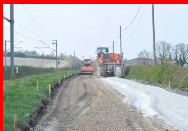
Le malaxeur entre en action après l'épandage du liant hydraulique.
