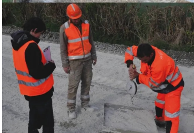
Véri cation de la quantité de liant hydraulique épandu par mètre carré, avec pesage d'un échantillon étalonné.
