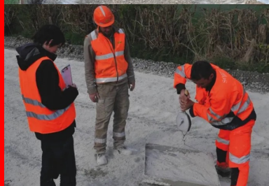
Vérification de la quantité de liant hydraulique épandu par mètre carré, avec passage d'un échantillon étalonné.
