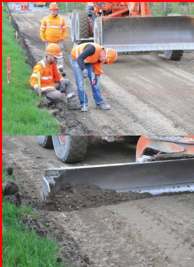
Prise de mesure de la hauteur de la chaussée retraitée avant réglage.
