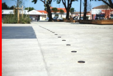
Des inserts pour le repérage du cheminement et l'éclairage en perspective. En médaillon, le béton noir lissé, réalisé côté est, pour créer un contraste.
