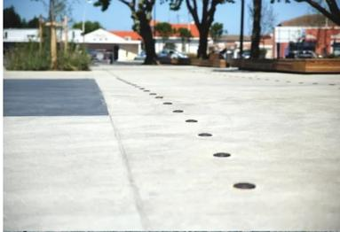
Des inserts pour le repérage du cheminement et l'e et de perspective. En médaillon, le béton noir lissé, réalisé côté est, pour créer un contraste.
