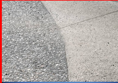
Autre exemple de la diversité des finitions (microbouchardage et désactivation), avec la maîtrise du scage et de l'intégration des joints au projet esthétique.
