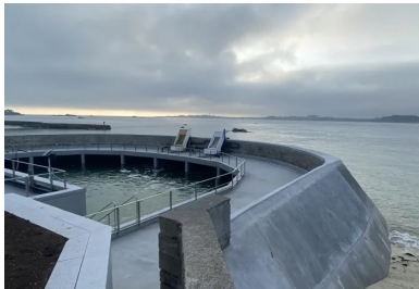
Le mur-poids retenant l'eau du vivier a été consolidé par une coque en béton projeté. La passerelle qui le parcourt a été reconstruite à l'identique.
