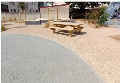
Bétons drainant et désactivé à Thionville. ©EQIOM
