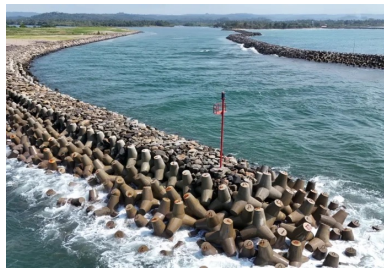
Brise-lames avec tétrapodes en béton. © Galih Pradipta/Shutterstock
