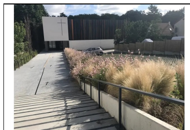
Béton drainant en aménagement désimperméabilisé à Montigny-lès-Cormeilles. © Maloudebo
