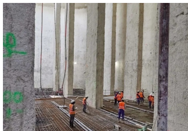
L'intérieur du bassin dévoile un volume monumental, émaillé par 32 barrettes. Ancrées à 81 m de profondeur, celles-ci garantissent la stabilité structurelle de l'ouvrage en toutes circonstances, notamment vis-à-vis des risques de soulèvement ou de basculement.
