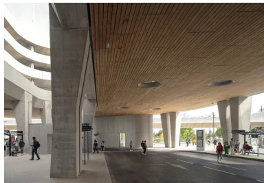
L'espace de la gare est totalement dégagé grâce à l'intégration de tous les équipements techniques.
