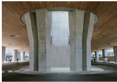
Les puissantes piles de béton du rez-de-chaussée ont été coulées en place.
