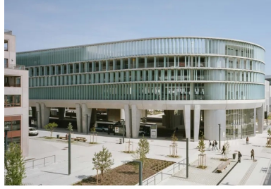
Le pôle multimodal superpose deux programmes clairement identifiés en façade : une gare de bus en rez-de-chaussée et un parking dans les étages.
