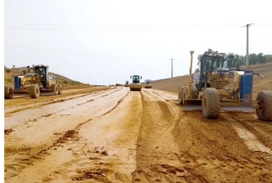
Réglage à la niveleuse pour obtenir un profil en long très régulier et atelier de compactage de la couche de forme traitée pour atteindre la compacité exigée.
