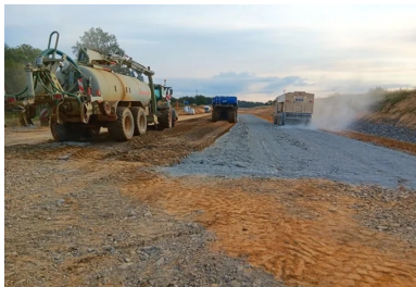
Épandage du LHR Rolac Premier ECOPlanet à la surface du matériau à l'aide d'un épandeur asservi avec contrôle pondéral. © Guintoli - NGE
