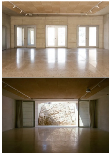
Parois en béton préfabriqué et dalle brute confèrent à la salle des associations sa massivité.
