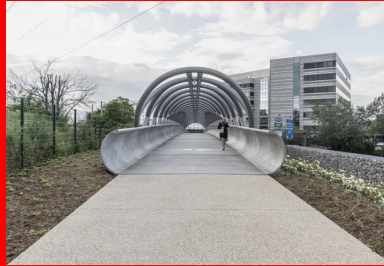
Le débord de l'emprise de la passerelle de part et d'autre du franchissement sécurise les usagers.
