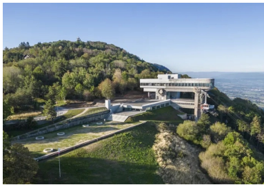
Façade est de la gare haute du téléphérique. Le béton plus clair correspond à l'extension de l'édifice.
