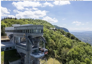
Proue de la gare haute dont l'implantation des piliers correspond au franchissement d'une zone calcaire instable.
